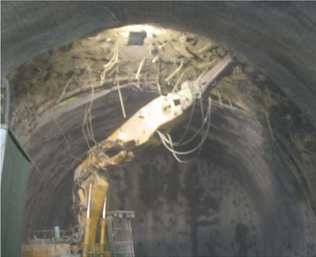
*Fig. 11 : Réalésage entre 1<sup>ère</sup> et 2<sup>ème</sup> phase au BRH*
