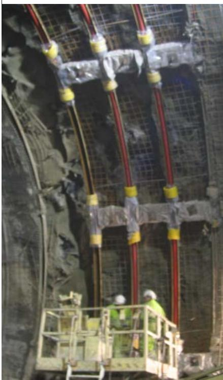
*Fig. 14: Pose des blocs compressibles sur les parements*
