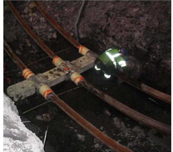
*Fig. 10 : Pose des blocs compressibles en contre-voûte*
