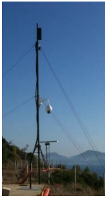
Figure 5 : Système FMCW en place
