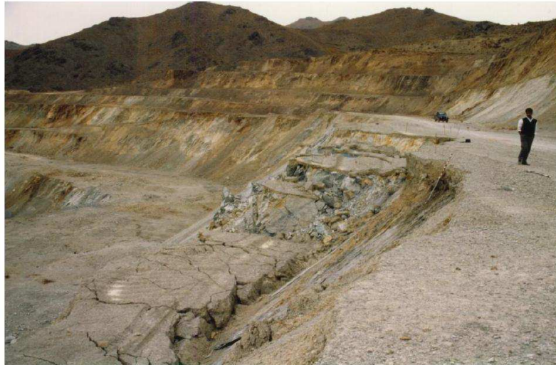
Figure 6. Flanc sud-ouest de la mine de cuivre de Sar Cheshmeh en Iran. Vue générale et mécanisme de rupture par dièdre, [COJ 01].
