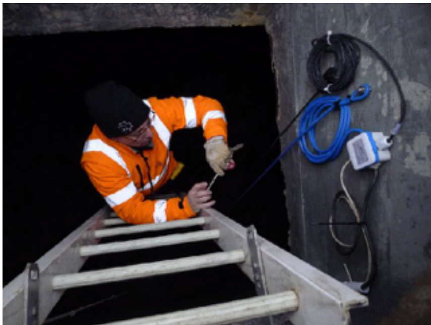
Figure 4. Inspecter un réservoir d'eau : descendre (© J. Denis)
